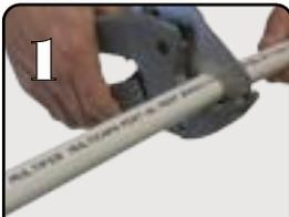
Cortar en ángulo recto la sección de tubo. En caso de usar tubería multicapa es obligatorio calibrar y biselar.
